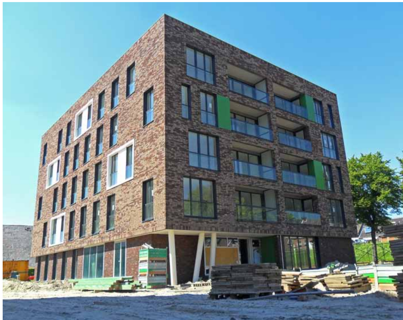
Een gevarieerde gevel bestaande uit handvormsteen in dikformaat.
